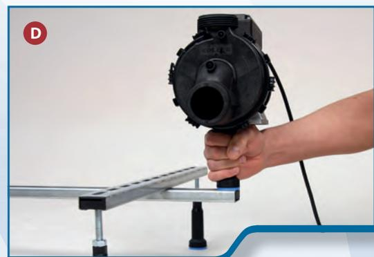
Zuletzt den unteren Nutstein in das C-Profil des Wannengestells einschieben. Durch Rechtsdrehen zieht sich Quick Fix Vario oben und unten gleichmäßig an. Die Pumpe nun nach räumlichen Erfordernissen beliebig ausrichten und durch feste Rechtsdrehung den Quick Fix Vario endgültig fixieren. Fertig!
